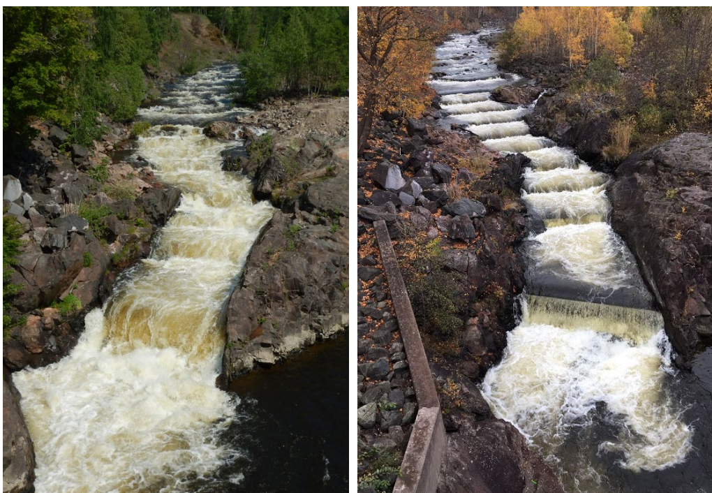
Figur 51 och 52. T.v. 9 m 3 /s genom fiskvägen. T.h. 3 m 3 /s genom fiskvägen före reparationen 2020. Foto: Fredrik Nilsson.
