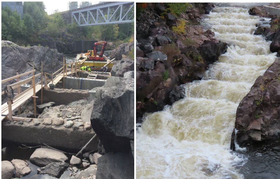
Figur 58 och 59. Vänster. Reparation utförs på fiskvägen 2020. Höger. Vatten påsläppt efteråt. Foto: Fredrik Nilsson.
