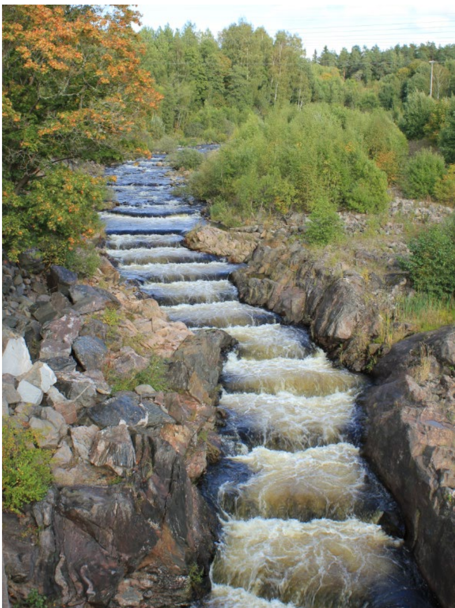
Figur 7. Gullspångsforsen med den fiskväg som anlades inom projekt Gullspångslaxen för att lax och öring ska kunna vandra upp i forsen. Foto: Frida Laursen.
